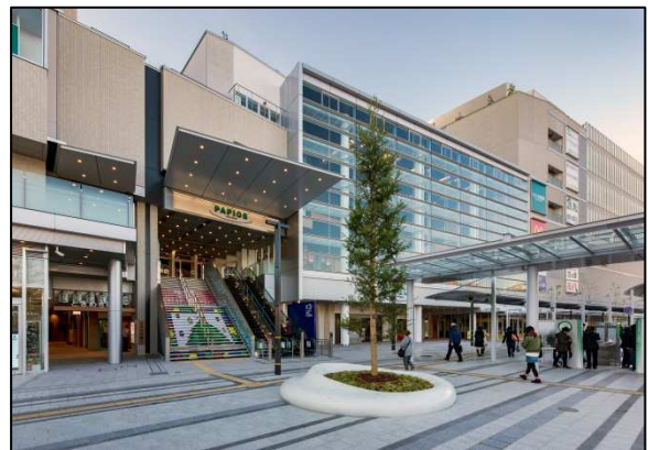
駅前広場からの施設棟外観
